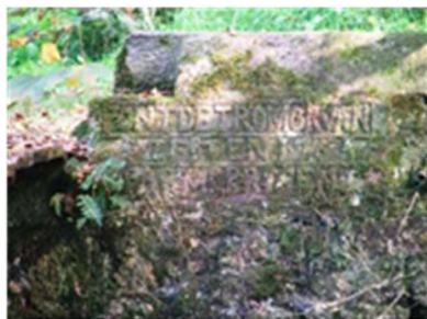
Pont du moulin de Traou Morvan
