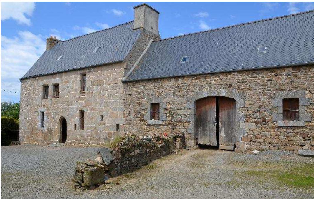
Exemple de bâtiment concerné à Ty Bras-ar-Lay
