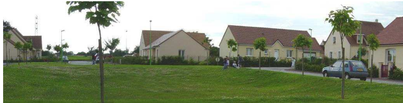
Bassin de rétention faible profondeur
