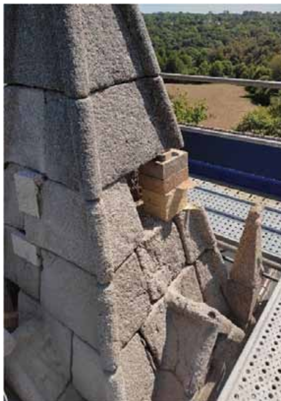
Le clocher en cours de restauration.
