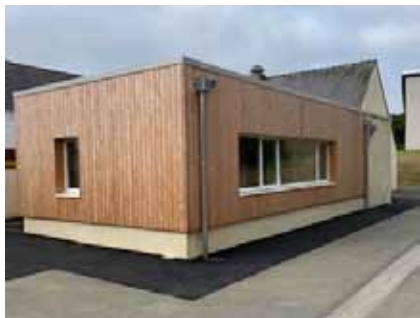
Bâtiment réalisé en bois
