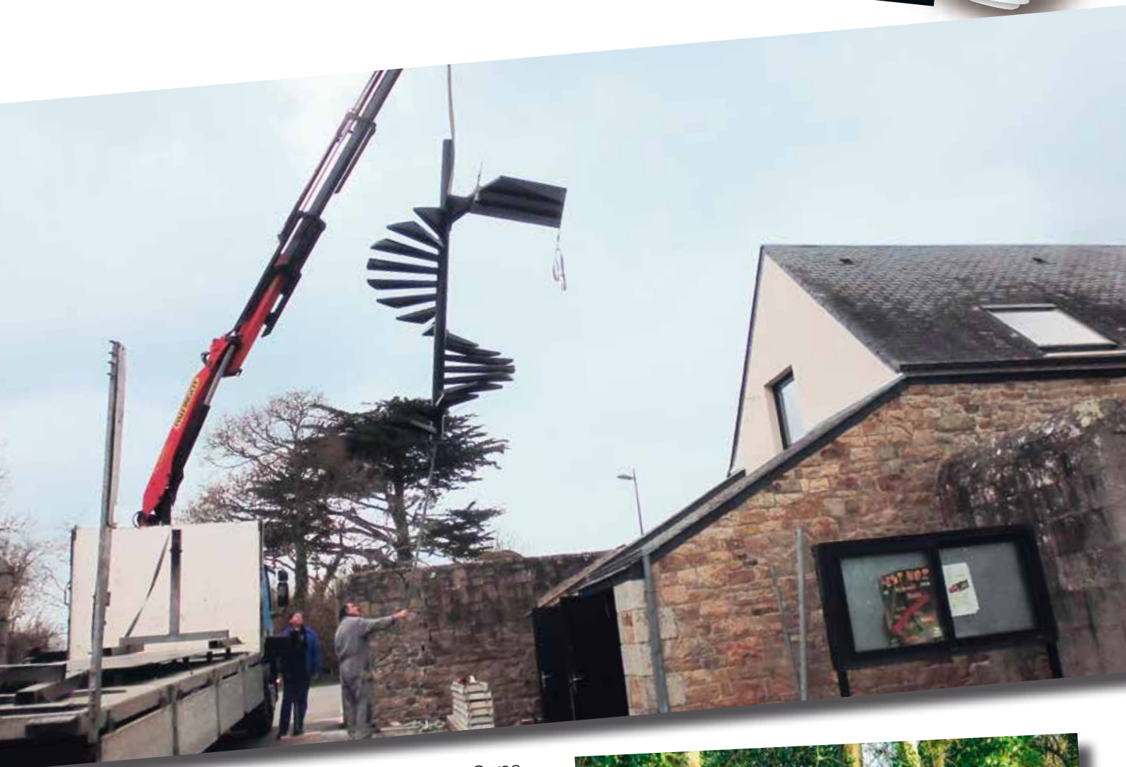
Installation de l'escalier extérieur de la bibliothèque au Carec
