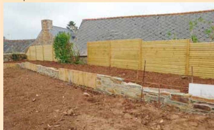
Aménagement en cours autour du monument aux morts
