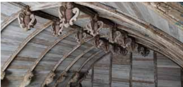
8. Voûte de l'aile Sud de la chapelle de Kerfons
