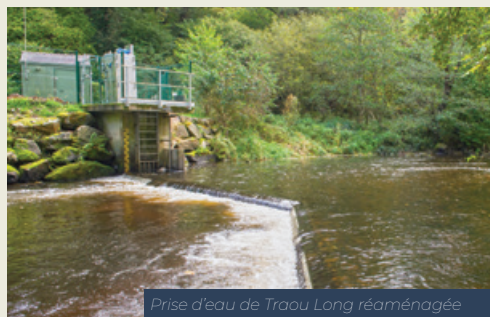
Prise d'eau de Traou Long réaménagée pour rétablir la continuité
