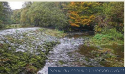
Seuil du moulin Guerson avant
