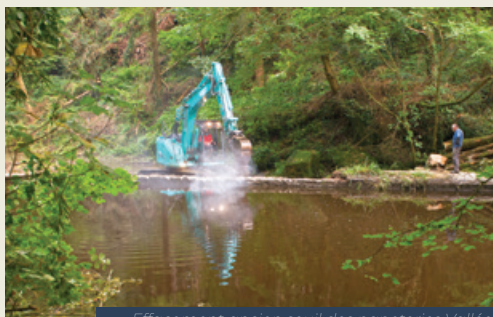
Effacement ancien seuil des papeteries Vallée
